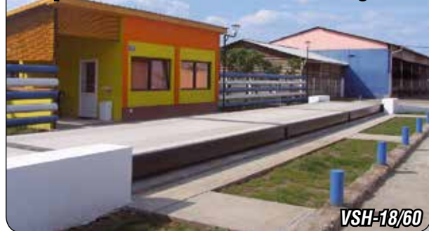
Rámás akna nélküli betonhidas hídmérleg
