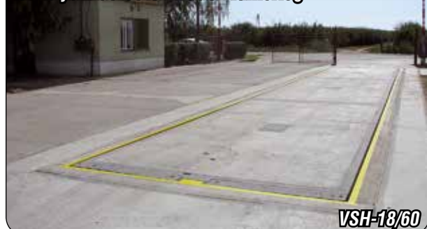
Sekélyaknás betonhidas hídmérleg
